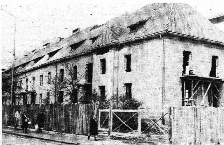
Delavci SGP Sava so pričeli s predelavo in povečanjem tretje železniške hiše na Plavžu. V njej je bilo doslej 12 stanovanj, po končani adaptaciji pa bo v njej 48 stanovanj, ker bodo stambo dvignili za dve nadstropji.
