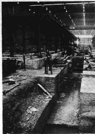
Temelji za lužilno-žarilno linijo
