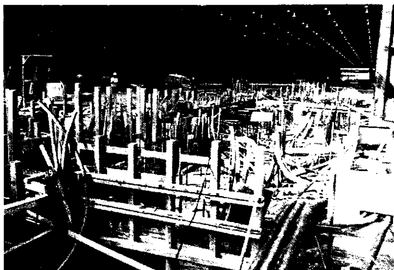
Z gradbišča nove hladne valjarne
