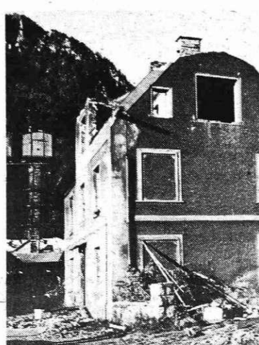
Zaradi neustreznih življenjskih pogojev postopno preseljujejo stanovalce iz Stare Save, zgradbe pa rušijo
