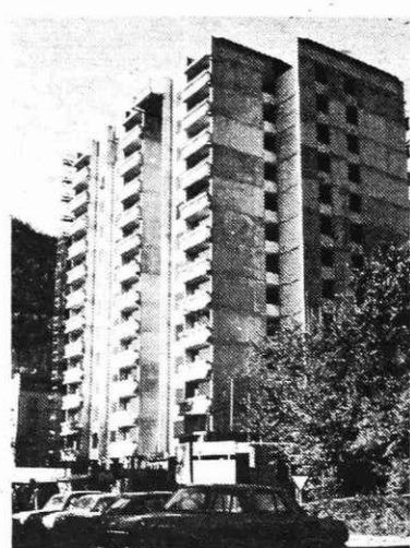
Stolpnica nasproti vrtca na Plavžu, v kateri bo 84 stanovanj, je v grobem gotova. Predvidevajo, da bo vseljiva v začetku prihodnjega leta
