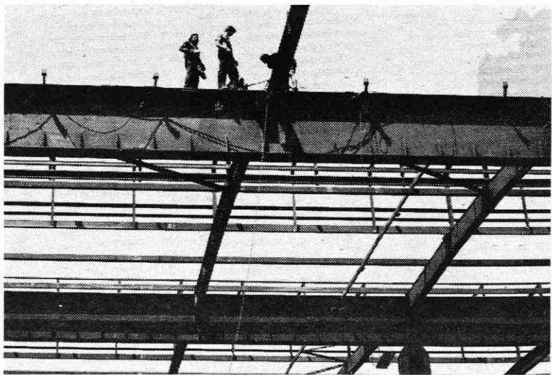
Človek in jeklo (Foto Lojze Mulič) – strešna konstrukcija nove hladne valjarne
