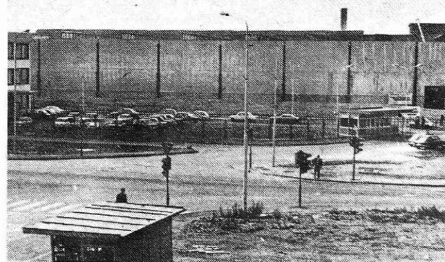
Vhod v valjarne s parkiriščem in delom objekta za laboratorije
