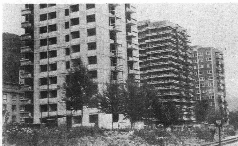
Dve novi stolpnici na Plavžu sta pod streho. V vsaki bo po 52 stanovanj, ki bodo predvidoma useljiva v začetku prihodnjega leta
