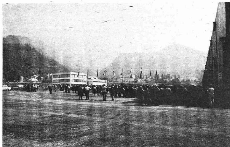
Pogled na u. ejeno okolje gradbišča hladne valjarne pred slavnostnim zborovanjem 23. avgusta
