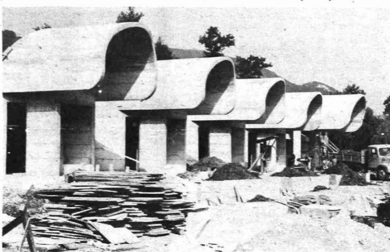
Mrliske vežice na Blejski Dobravi gradijo delavci SGP Sava Jesenice. Predvidevajo, da bodo zgrajene do dneva mrtvih, 1. novembra
