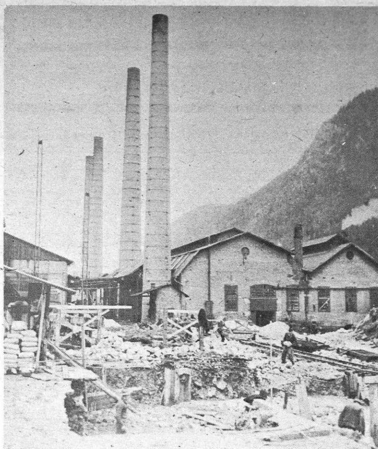
V drugi polovici leta 1936 so pričeli kopati jamo za temelj novega plavža. Pogled na staro martinarno očitno kaže, da so takrat obratovali štiri SM peči.
