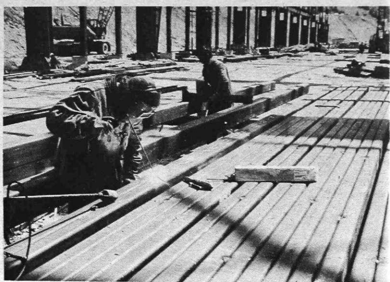
Strešne konstrukcije za novo hladno valjarno varijo že pod streho
