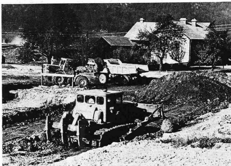
Zemeljska dela pri urejanju uvozne in izvozne ceste v valjarni Bela in jeklovlek
