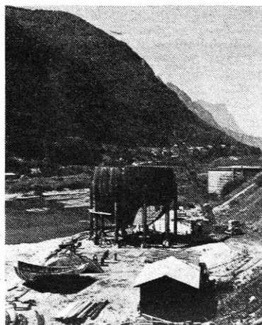
Nov rezervoar za propan-butan ob Savi
