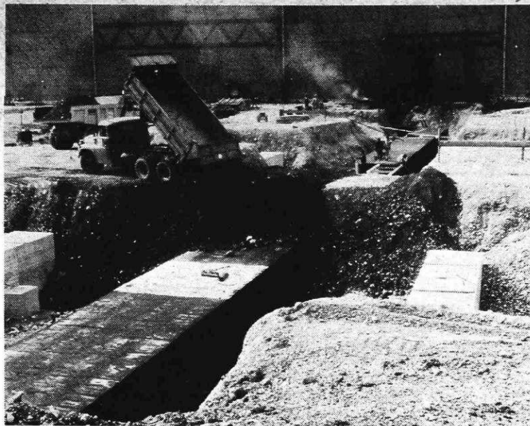
Zasipanje energetskega kanala, ki poteka pod halo nove hladne valjarne
