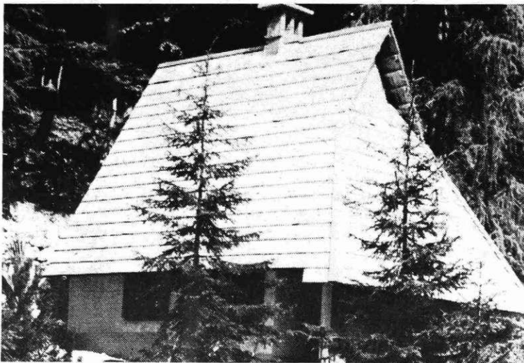
V nedeljo, 4. avgusta, so člani Smučarskega društva Jesenice odprli novo smučarsko zavetišče v Suhi Pišenci, v neposredni bližini poletnega smučišča na plazu pod Prisojnikom. Zgradili so ga pretežno s prostovoljnimi delom, z materialom pa sta največ pomagala Železarna in SGP Sava Jesenice.
