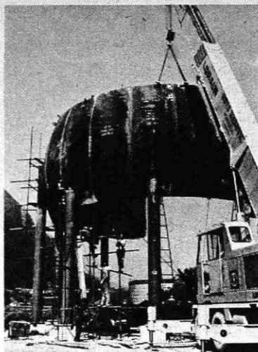
Montaža rezervoarja (1200 kub. metrov) za butan — propan s pretakalščem na Beli
