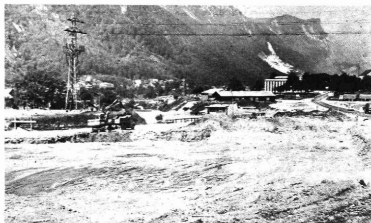
Izkop za garderobe nove hladne valjarne
