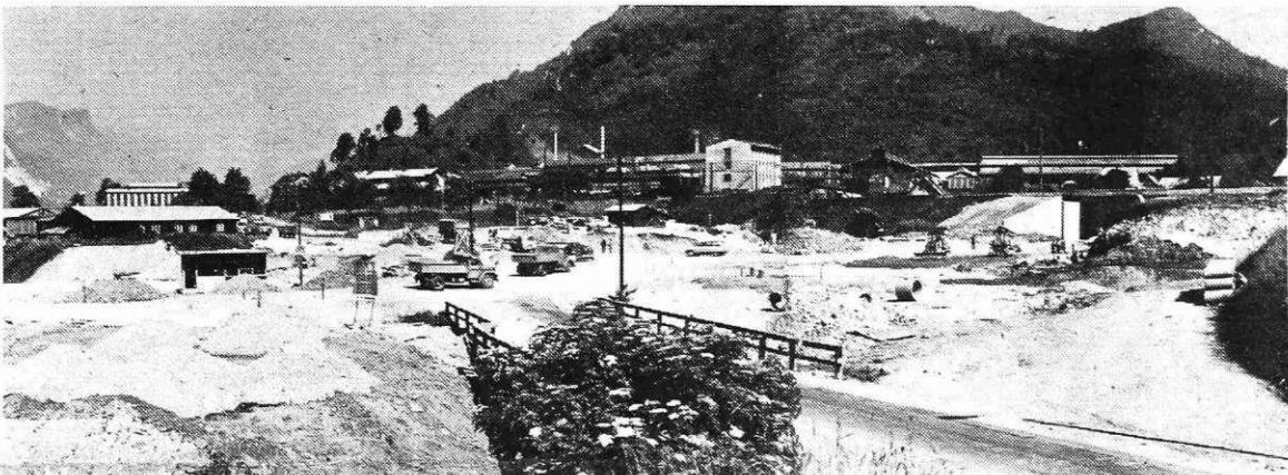
Gradnja nove hladne valjarne je zajela izredno obsežen kompleks del
