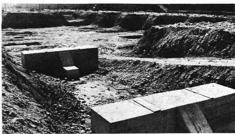
Prvi temelji za novo hladno vodo
