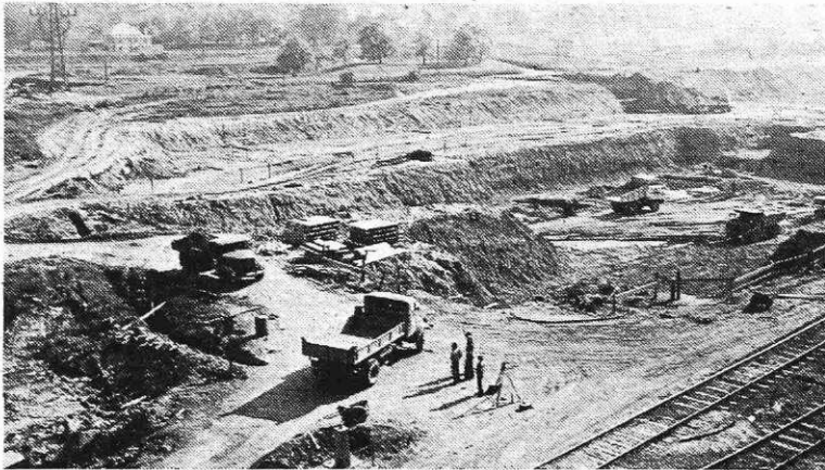
Izkop temeljev za novo hladno valjarno na Beli
