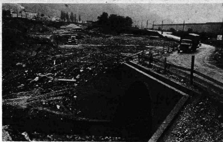
Zemeljska dela na objektu nove hladne valjarne kljub deževnemu vremenu dobro napredujejo
