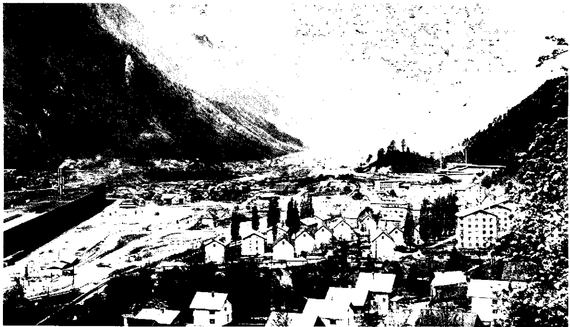
Gradbišče za novo hladno valjarno in premaknjeno cestišče.
