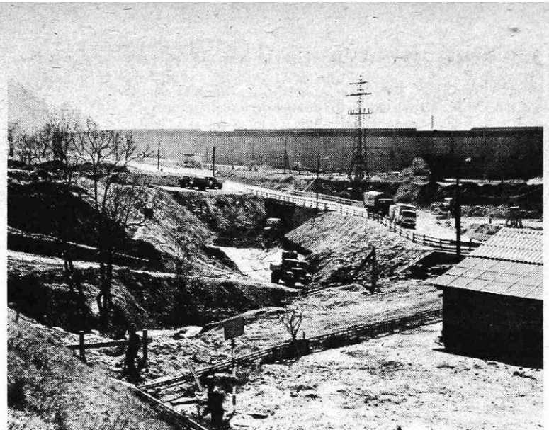
Dela pri gradnji novega križišča ob valjarnah Bela
