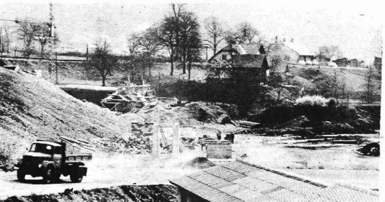
Gradbišče nove hladne valjarne dobiva vedno večje razsežnosti
