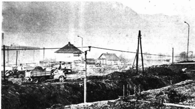
Med sedanjo cesto prvega reda in železniško progo na Beli, so začeli z zemeljskimi deli za novo traso ceste, ker se stara mora umakniti zaradi gradnje nove hladne valjarne. Nova cesta bo predvidoma gotova do 1. maja.
