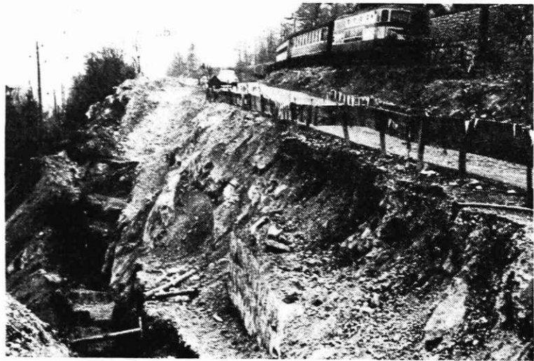
Rekonstrukcija glavne gorenjske ceste skozi Sotesko je dokaj težavna, ker je na tem odseku med Potoki in Koroško Belo zelo tesen prostor. Ko bodo pod prostorom, kjer je bila odstreljena skala, zgradili oporni zid, bo najtežji problem rešen. Pri cestnem podjetju Kranj, ki vodi rekonstrukcijska dela in SGP Sava, katerega delavci grade oporne zidove, predvidevajo, da bo ta odsek nared in asfaltiran do poletne turistične sezone, ko je tu promet največji.
