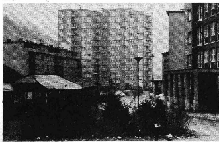
Delavci SGP Sava Jesenice, so v rekordnem času spravili pod streho novo 104 stanovanjsko stolpnico na Plavzu. Predvidevajo, da bodo stanovanja, v kateri se bodo vselili predvsem delavci Železarne, vseljena do poletja prihodnjega leta.
