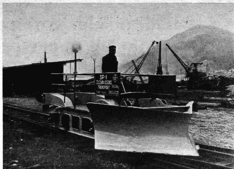
Delavci transporta in TOZD VET, imajo pripravljene cestne in železniške snežne pluge za boj proti snegu. Tirni plug so opremljeni s hidravlično dvigalko, ki omogoča lažje dviganje pluga, kjer je to med oranjem snega potrebno.
