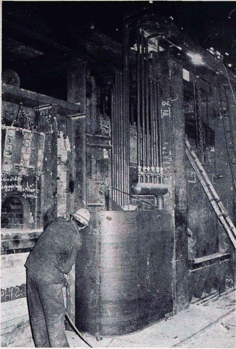
Rekonstrukcija SM peči v martinarni je zahtevala obvežna dela.
