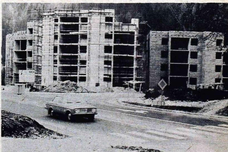
Delavci SGP Sava z Jesenic v Kranjski gori gradijo stanovanjski trojček s 39 stanovanji. Predvidevajo, da bo eno stopnišče useljivo še letos, ostala dva pa v začetku poletja prihodnje leto. Podjetje gradi ta stanovanja za prodajo. Namenjena so predvsem gostinskim delavcem, med katerimi pa ni toliko povpraševanja in jih bodo lahko kupile tudi druge organizacije in posamezniki.
