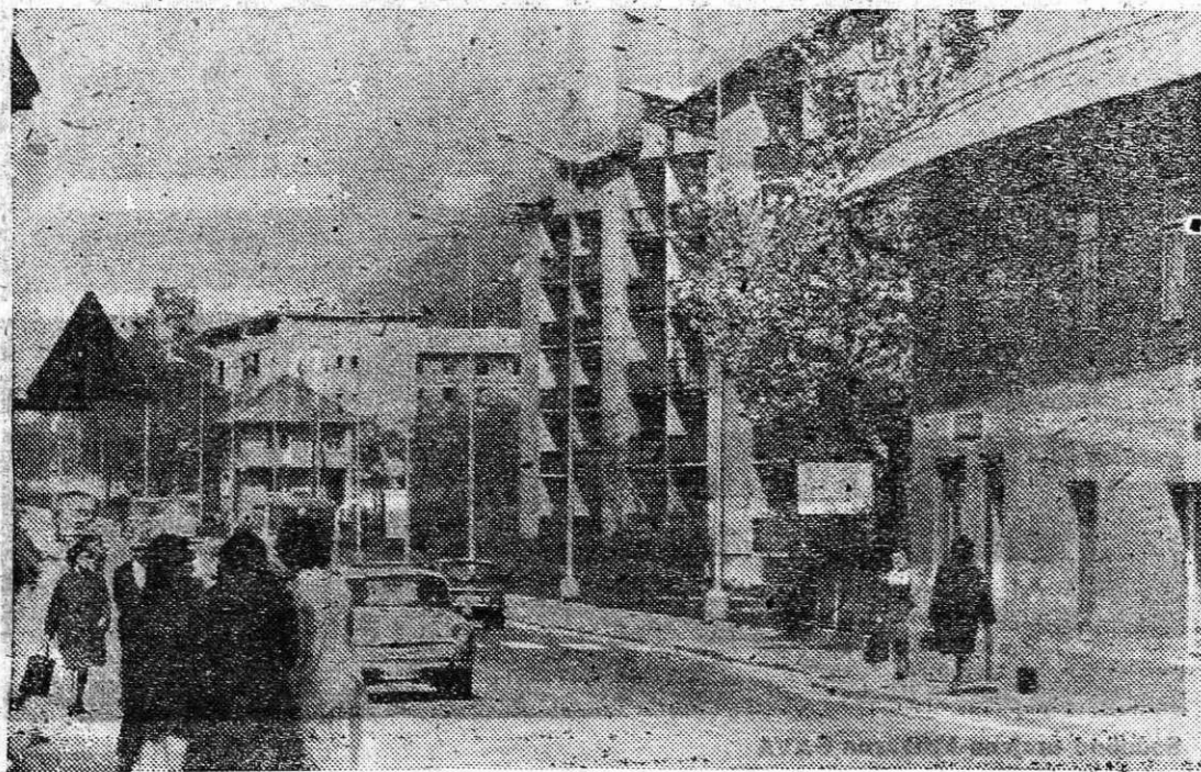
Prehod iz starega dela Jesenic v novo naselje Plavž
