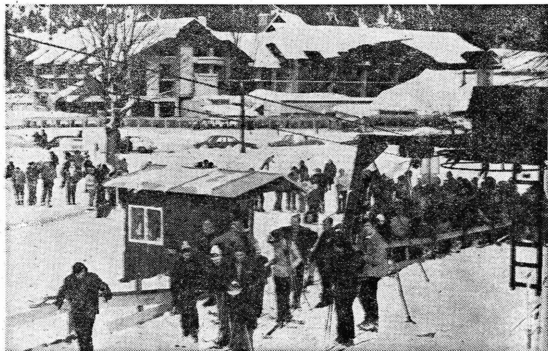
Za vlečnico Podles je novi hotel Kompas v Kranjski gori. Zgradbo so delavci GIP Gradis do zime spravili pod streho. Ko bo poslopje dograjeno, bo to največji hotel na Gorenjskem, saj bo imel 420 postelj. V njem bo tudi pokrit bazen in avtomatsko keglišče.
