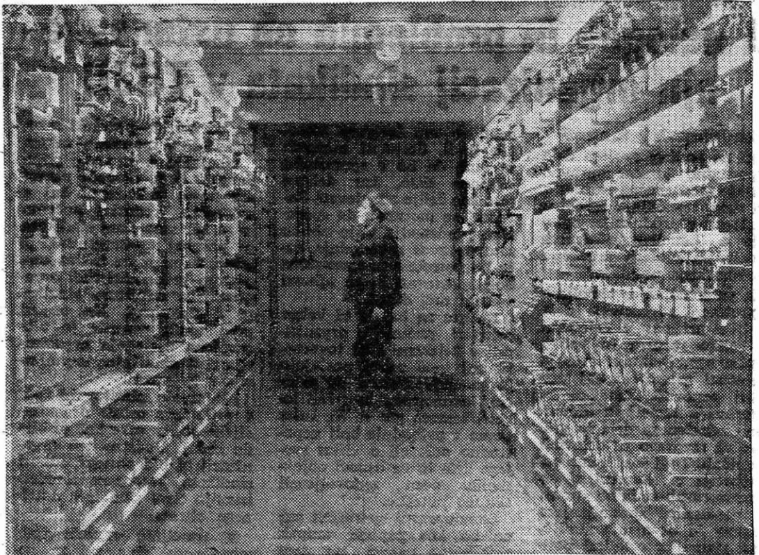
Stiskalni prostor I za transport surovin iz silosov aglomeracije na plavž II
