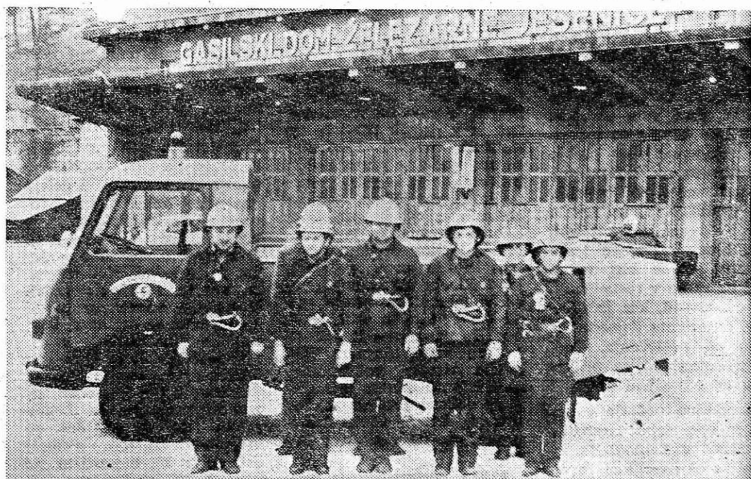
Poklicna gasilska reševalna četa železarnje Jesenice je zadnje dni lanskega leta dobila novo gasilsko vozilo za suho gašenje. Avtomobil, ki ga vidimo na sliki, prevaža 500 kg posebnega prahu, ki ima to lastnost, da pogasi ogenj z zadušitvijo in ohlajevanjem. To vozilo je zelo pripravno za gašenje električnih in oljnih požarov. Vozilo je izdelalo podjetje Tam v Mariboru, gasilske naprave pa so naredili in instalirali v tovarni gasilske opreme »Pastor«, v Zagrebu. B.
