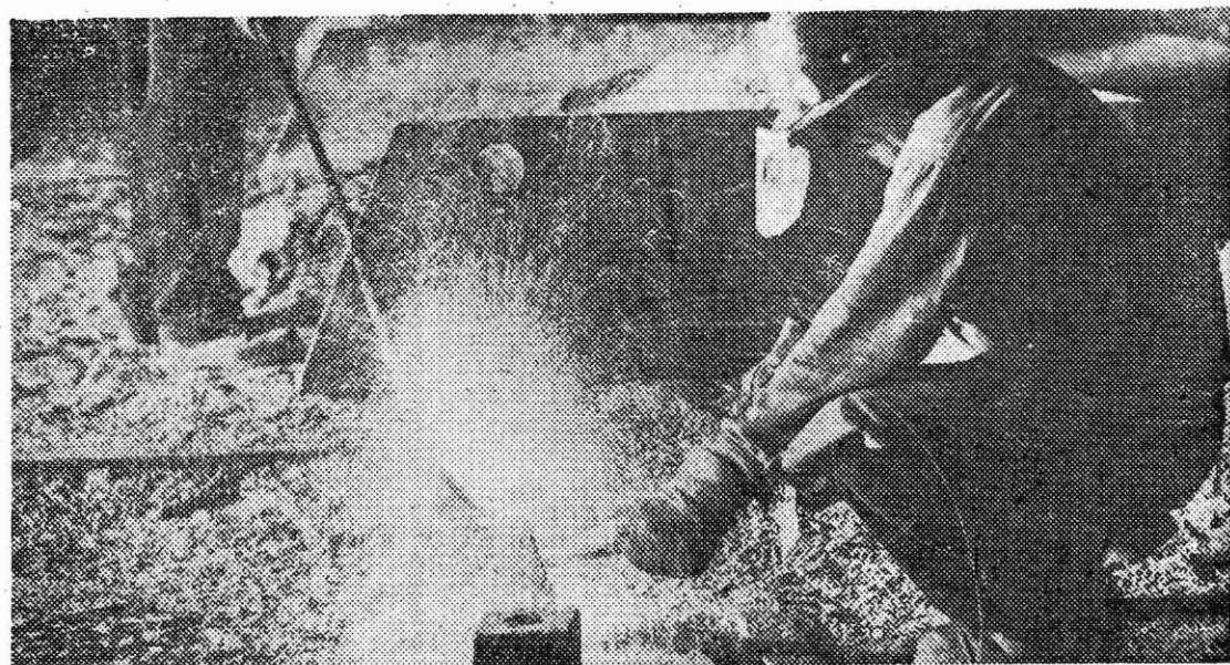
Jemanje vzorca v jeklarni
