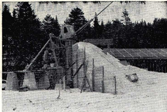
Zaradi predvidenih velikih graditev turističnih objektov in naprav v Kranjski gori, je SGP Sava z Jesenic v Jasni ob Pišenci postavilo novo betonarno. Iz velikega prodišča bodo črpali prod in ga spreminjali v betonsko mešanico. S tem bodo odstranili ogromne količine peska, ki ob nalivih grozi že tako premajhni strugi Dolinke.
