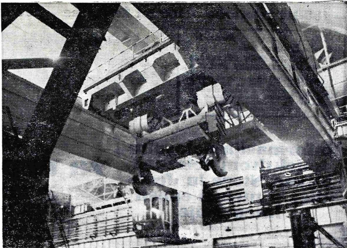
Nov 125 tonski žerjav v livni jami je omogočil mesečno povečanje proizvodnje za več kakor 1000 ton
