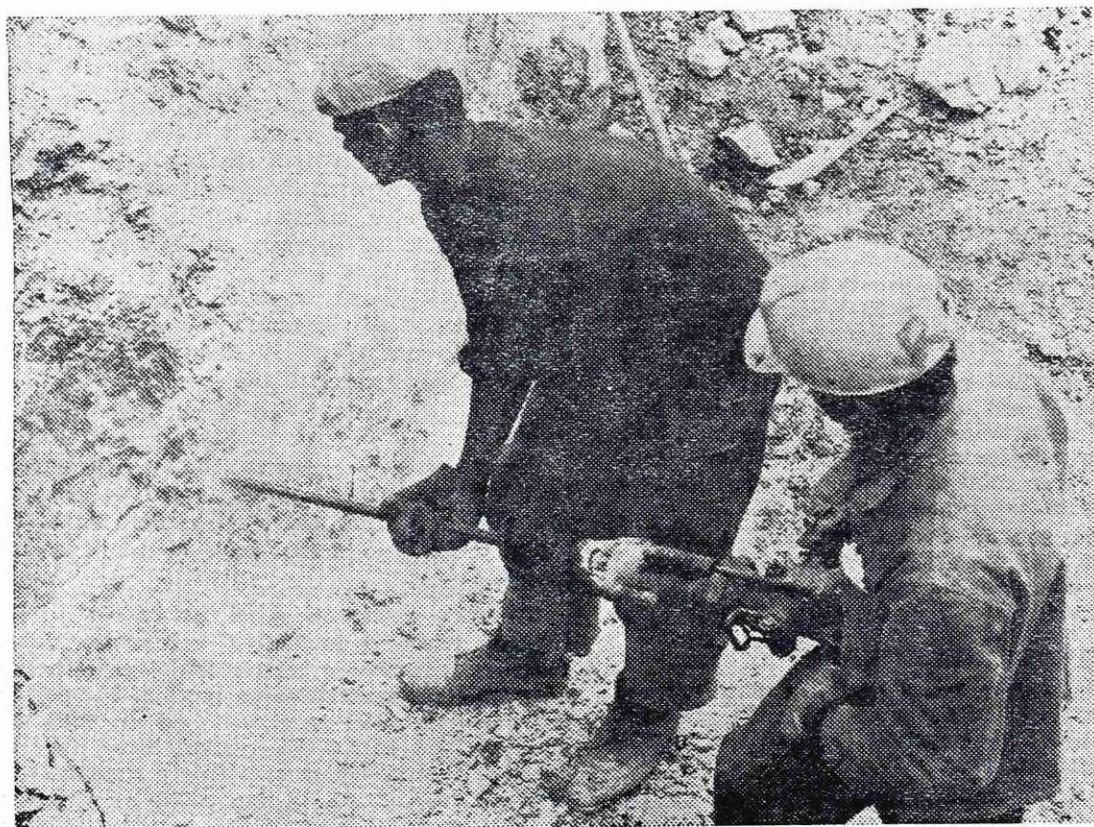
Zemeljska dela pri gradnji nove aglomeracije
