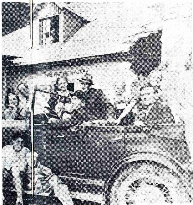
za kakršnokoli prevaro — osebni avtomobil je resnično pred do starega Valvazorjevega doma
