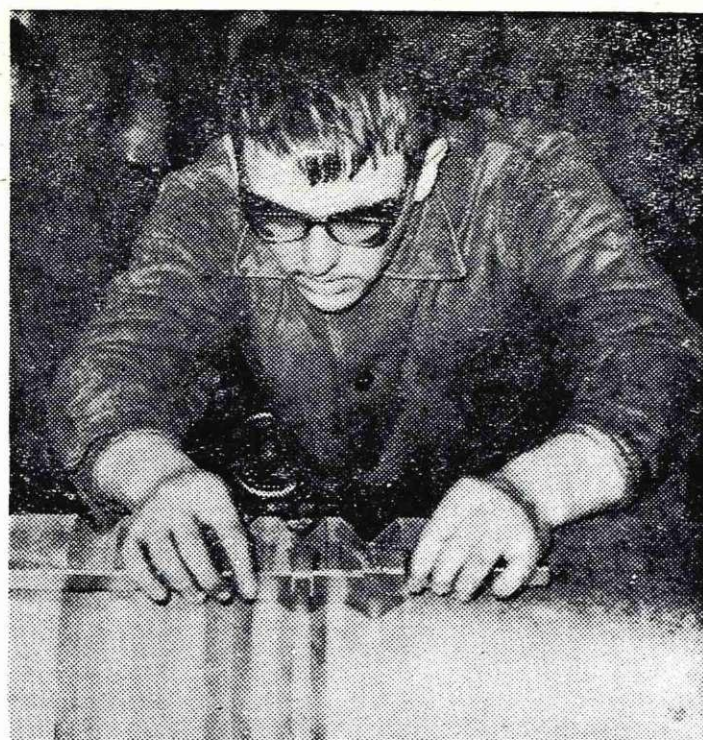
Šabloniziranje valjev za predprogo v stari valjarni žice (proga Ø 330)
