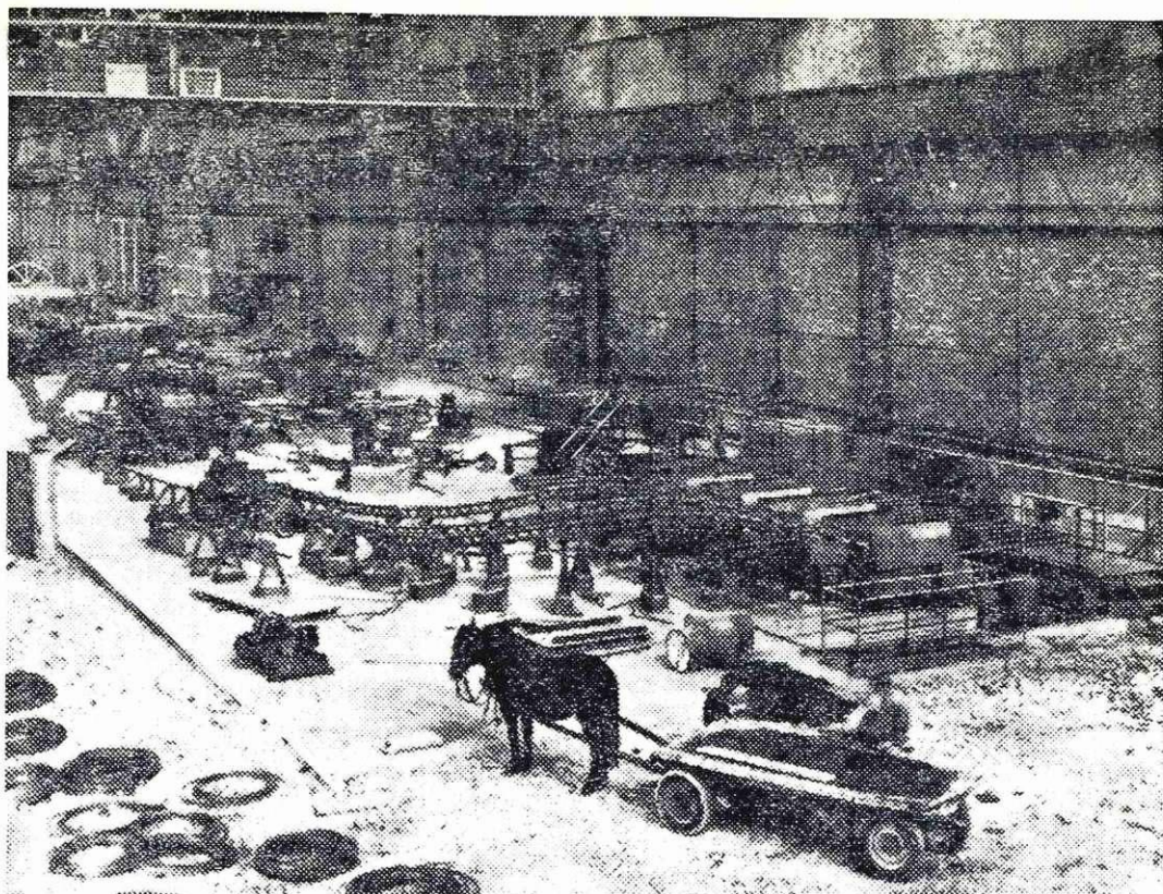
Zastarel motiv montažnih del v novi valjarni žice, ki bi morala v prihodnjem mesecu doseči 3.000 ton proizvodnje
