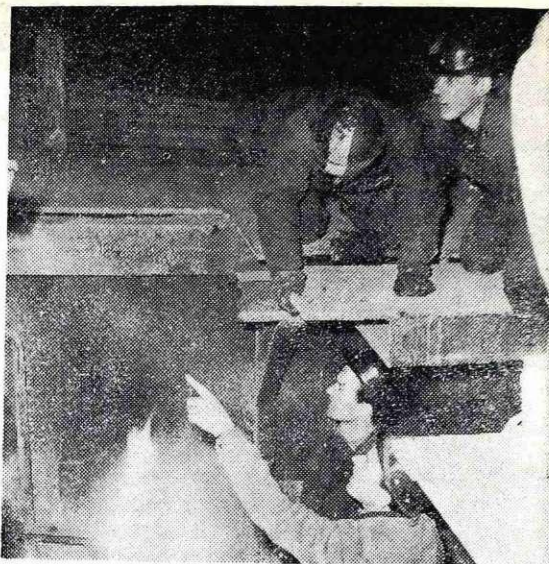
Delavci pri remontu električne peči
