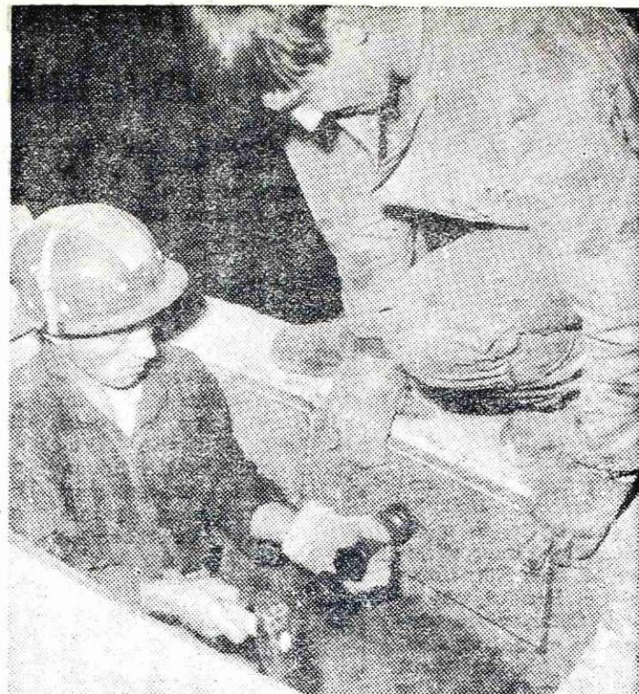
Streljanje izolacijskih plošč v glave kokile B 8
