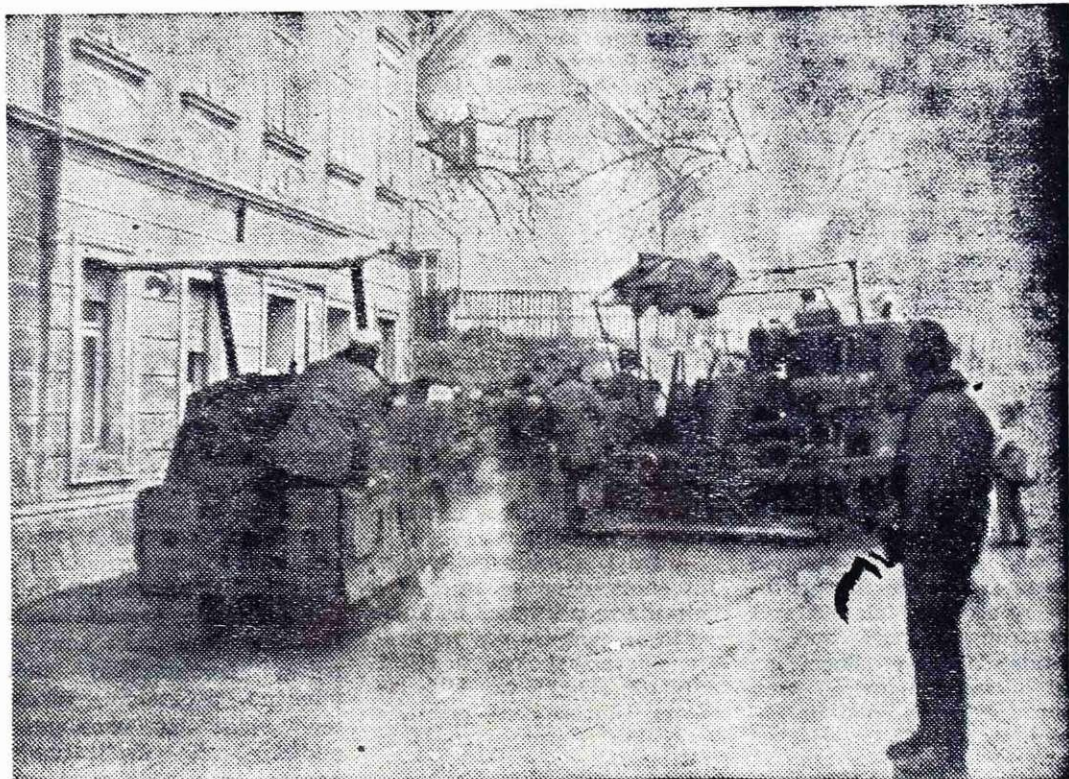
Cesto talcev že asfaltiralo
