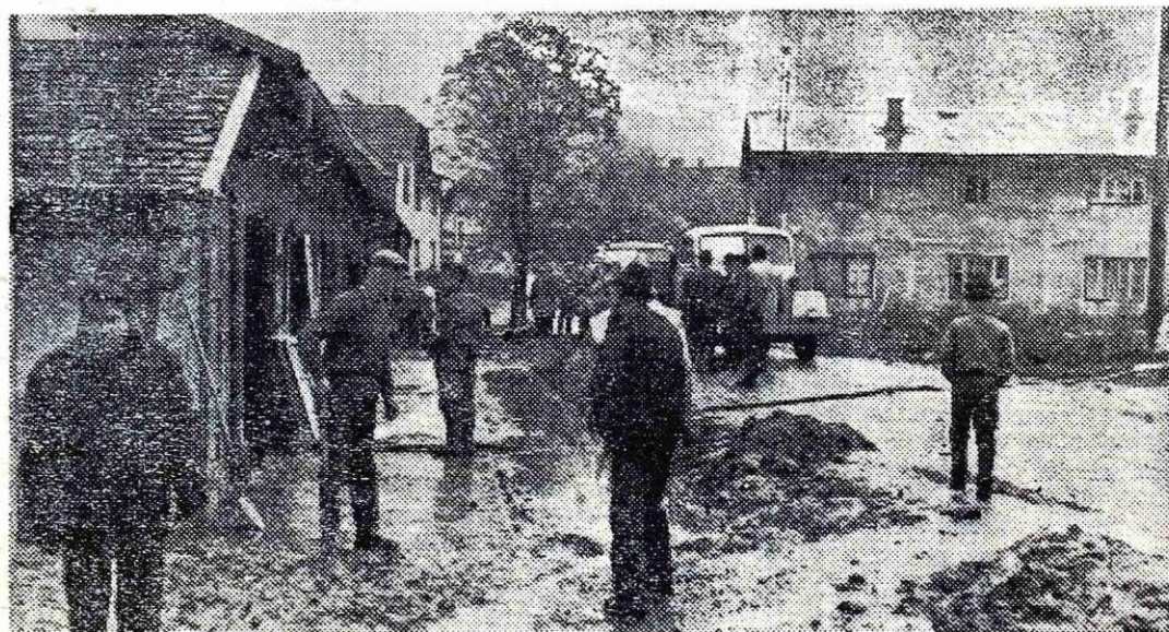
Stanovalci in posebnaskupina naših gasilcev je odstranjevala blato iz stanovanj. Delo so naši gasilci opravili zelo hitro in z močnim curkom vode.
