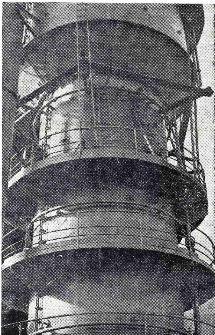
Nove čistilce plina bodo prepleskali
