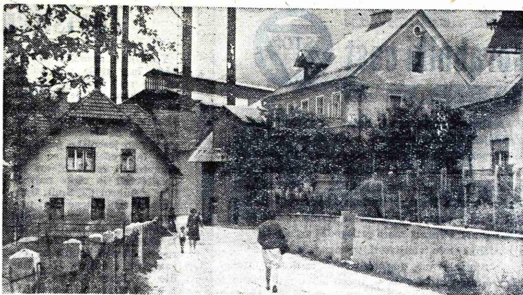
Pri rekonstrukciji ceste bodo morali porušiti Jalnovo (Dežmanovo) hišo in Prešernovo garažo ter preseliti več ograj
