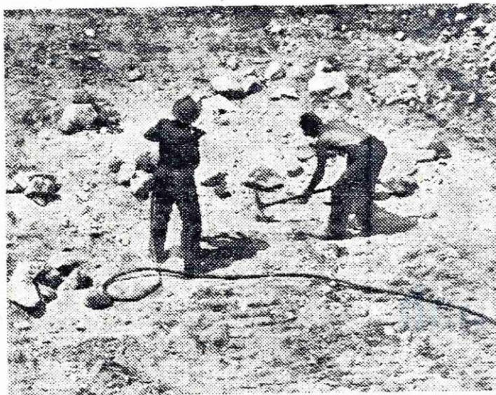
Gradisovci kopljejo jamo za stolp objekta 04
