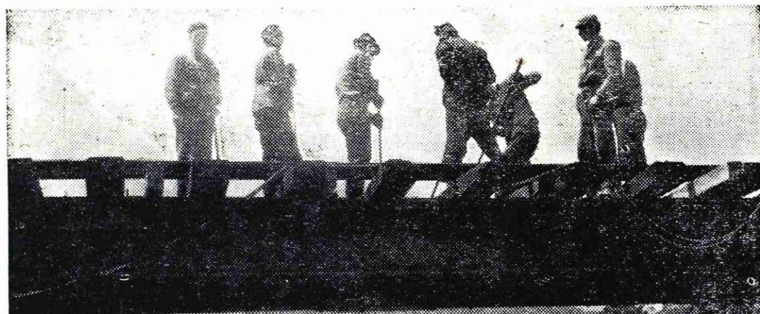
Izkop 100-metrške jame za vsipnik; na sredi so stebri za transportni trak
