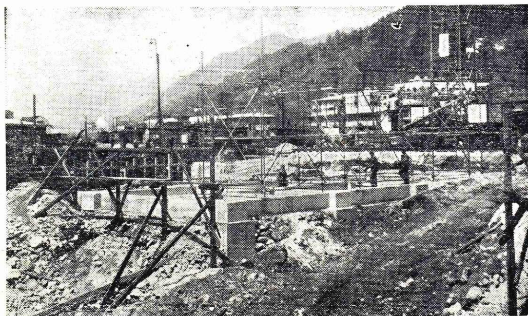
Temelji za presipno postajo, drobilnico in transformatorsko postajo
