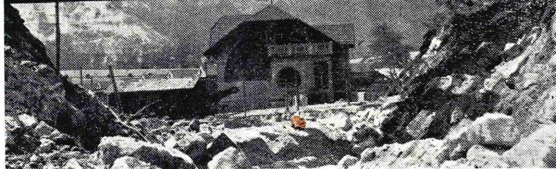
Industrijski tir za razkladanje koksa so premostili, da bodo izkopali tunel za trak 210
