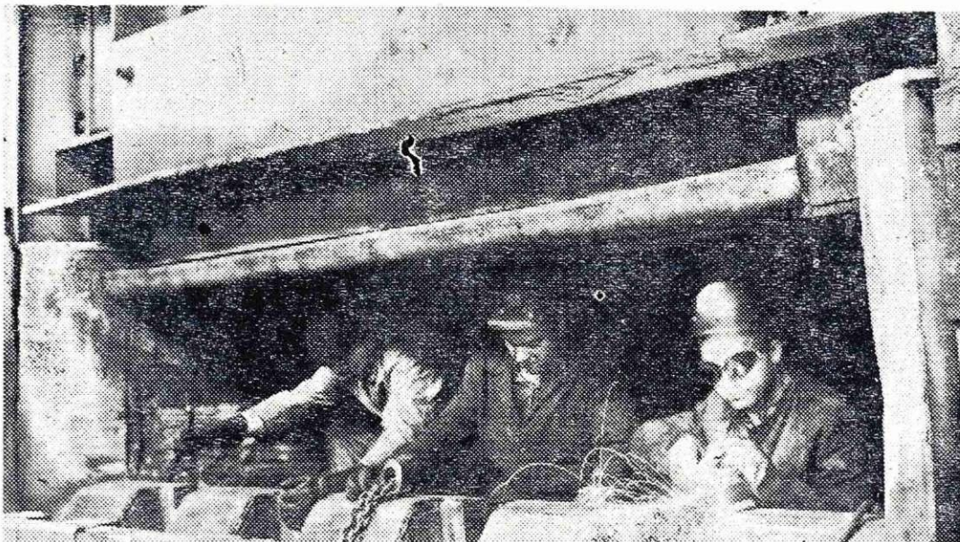
Vstavljanje novega vstopnega praga na potisni peči v valjarni 2400
