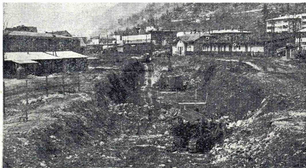
Tudi dela na gradbišču nove aglomeracije dobro napredujejo. Kopanje 100-metrskega rova za skladišče koksa
