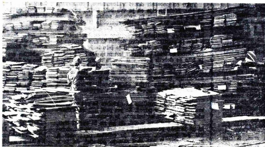
V valjarni tanke pločevine bodo letos delno dobili vložek že iz Bluming valjarne. Doslej je zanje valjala »platine« težka proga
