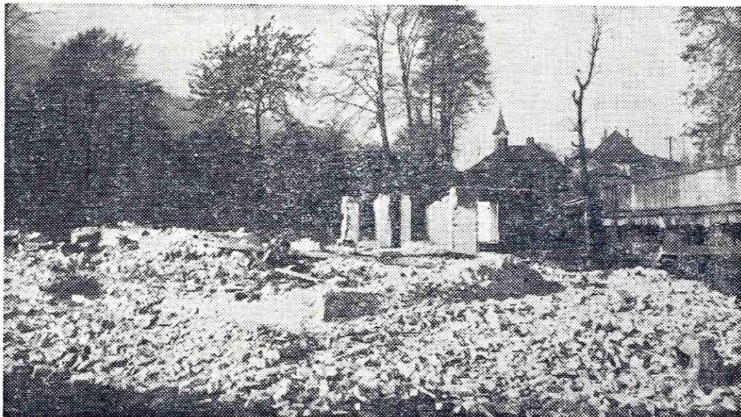
Na Stari Savi so podrli že več hiš, stanovalce pa preselili v sodobnejša stanovanja. Kjer je stala dolgo vrsto let »kantina«, je le še kup odpadnega gradiva
